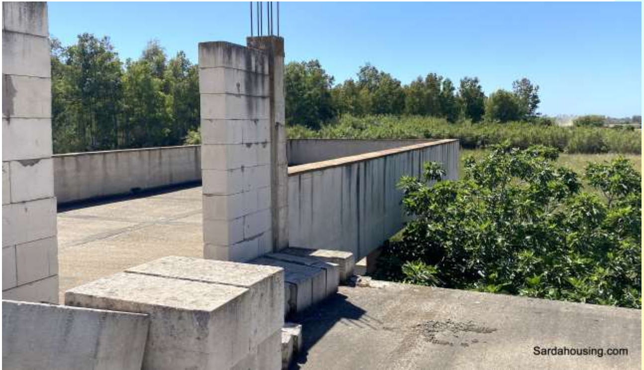
7 - Màssama – Oristano: Casale Màssama – main building
