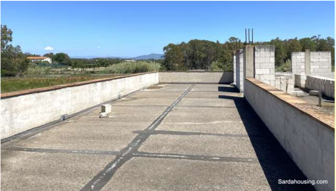
15 - Màssama – Oristano: Casale Màssama – main building
