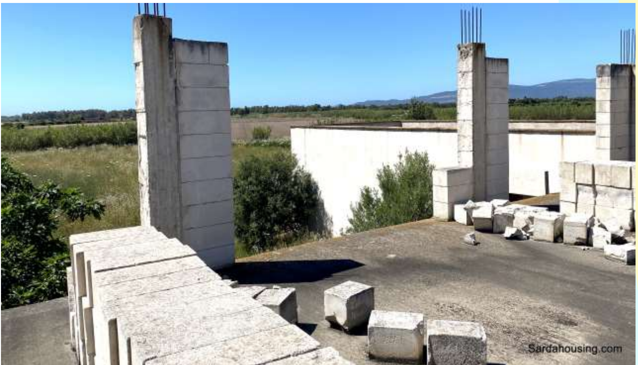
6 - Màssama – Oristano: Casale Màssama – main building
