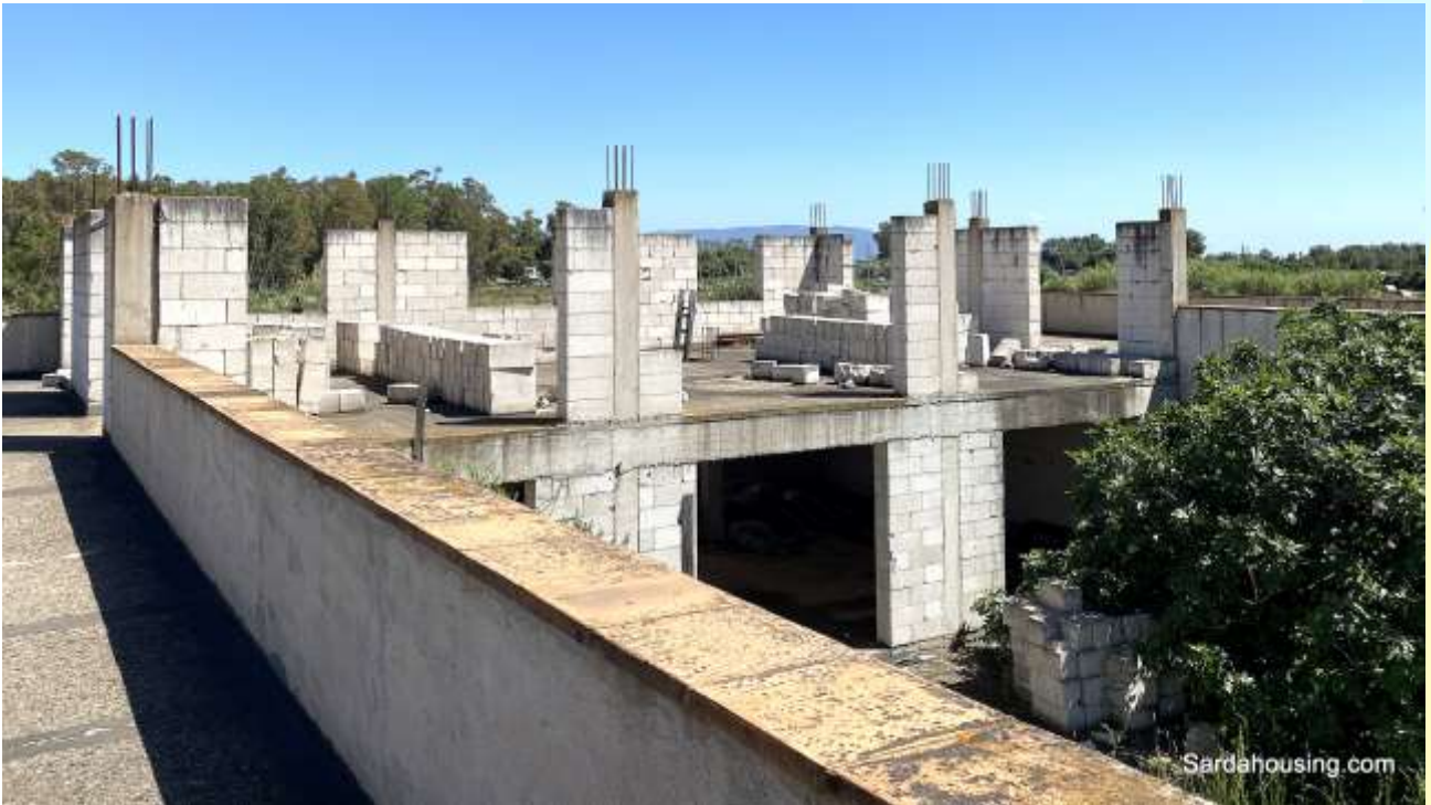
13 - Màssama – Oristano: Casale Màssama – main building
