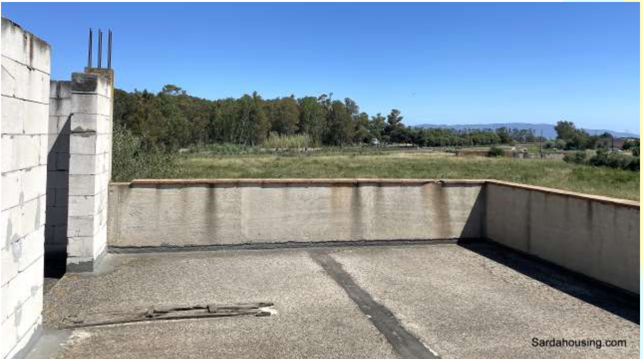
16 - Màssama – Oristano: Casale Màssama – main building
