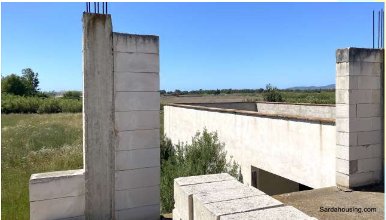
8 - Màssama – Oristano: Casale Màssama – main building
