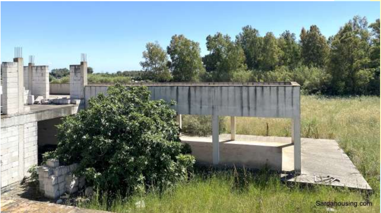
14 - Màssama – Oristano: Casale Màssama – main building
