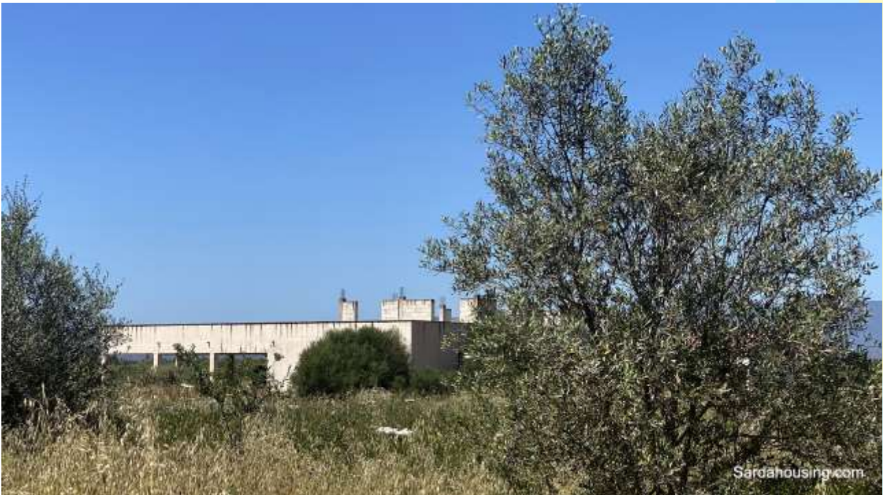
4 - Màssama – Oristano: Casale Màssama – main building
