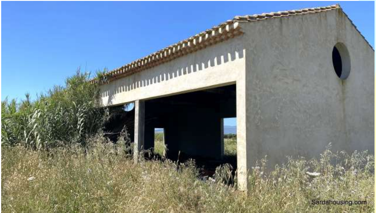
17 - Màssama – Oristano: Casale Màssama – edificio secondario
