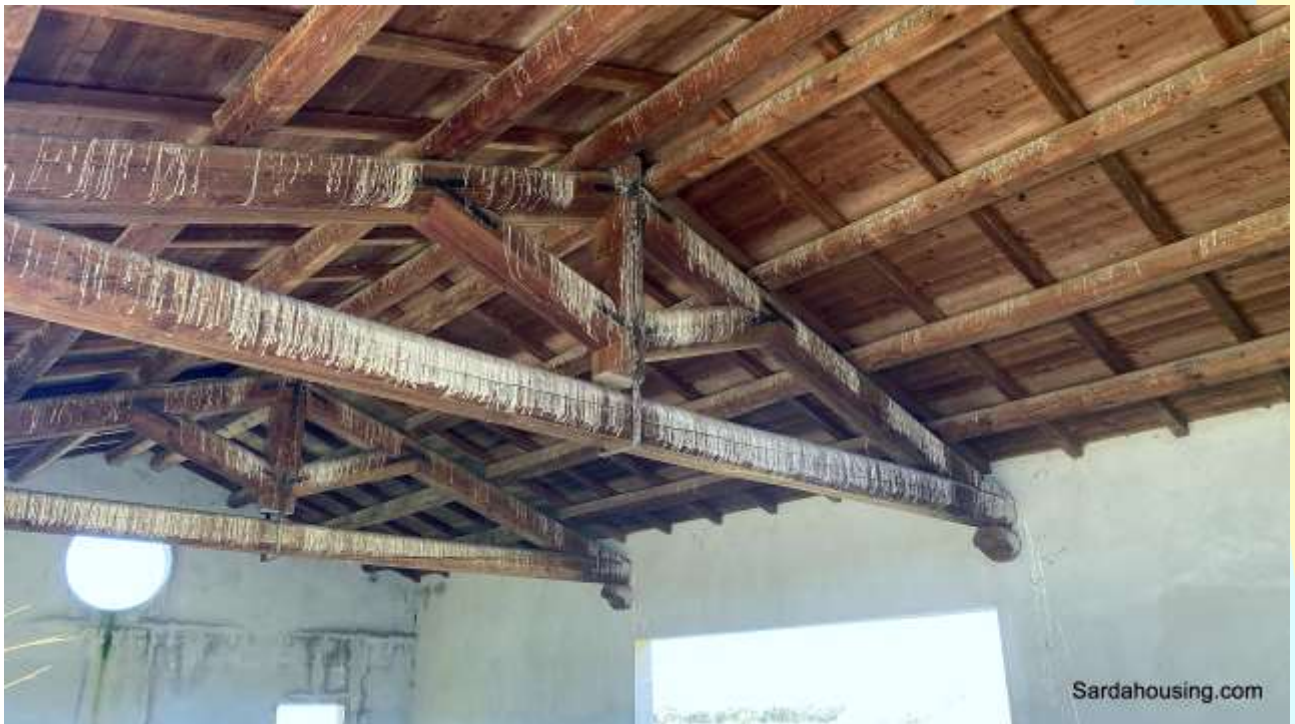
18 - Màssama – Oristano: Casale Màssama – edificio secondario
