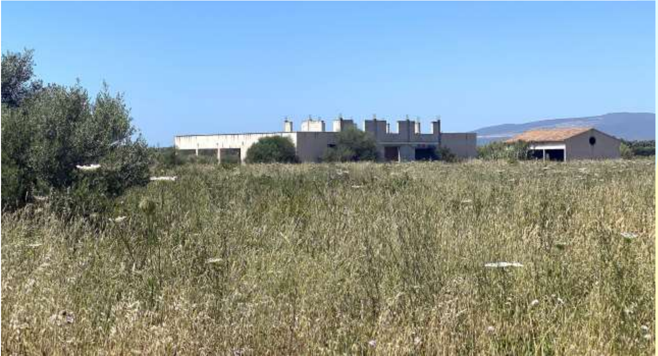
2 – Màssama – Oristano: edifici della tenuta
