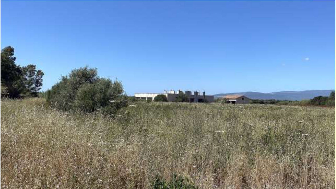
1 – Màssama – Oristano: edifici della tenuta
