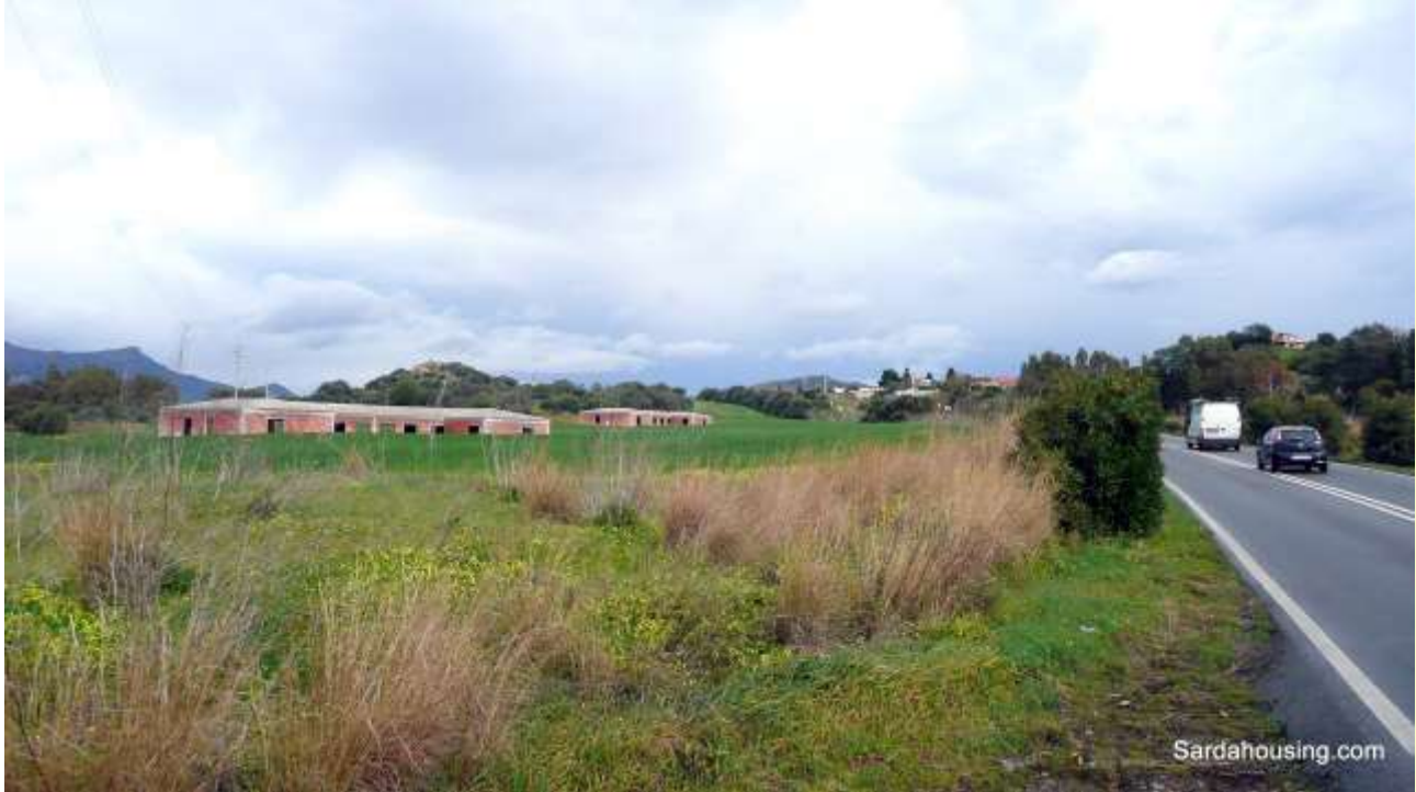
1 – Pula – Terreno Sulcitana: i due edifici dalla strada
