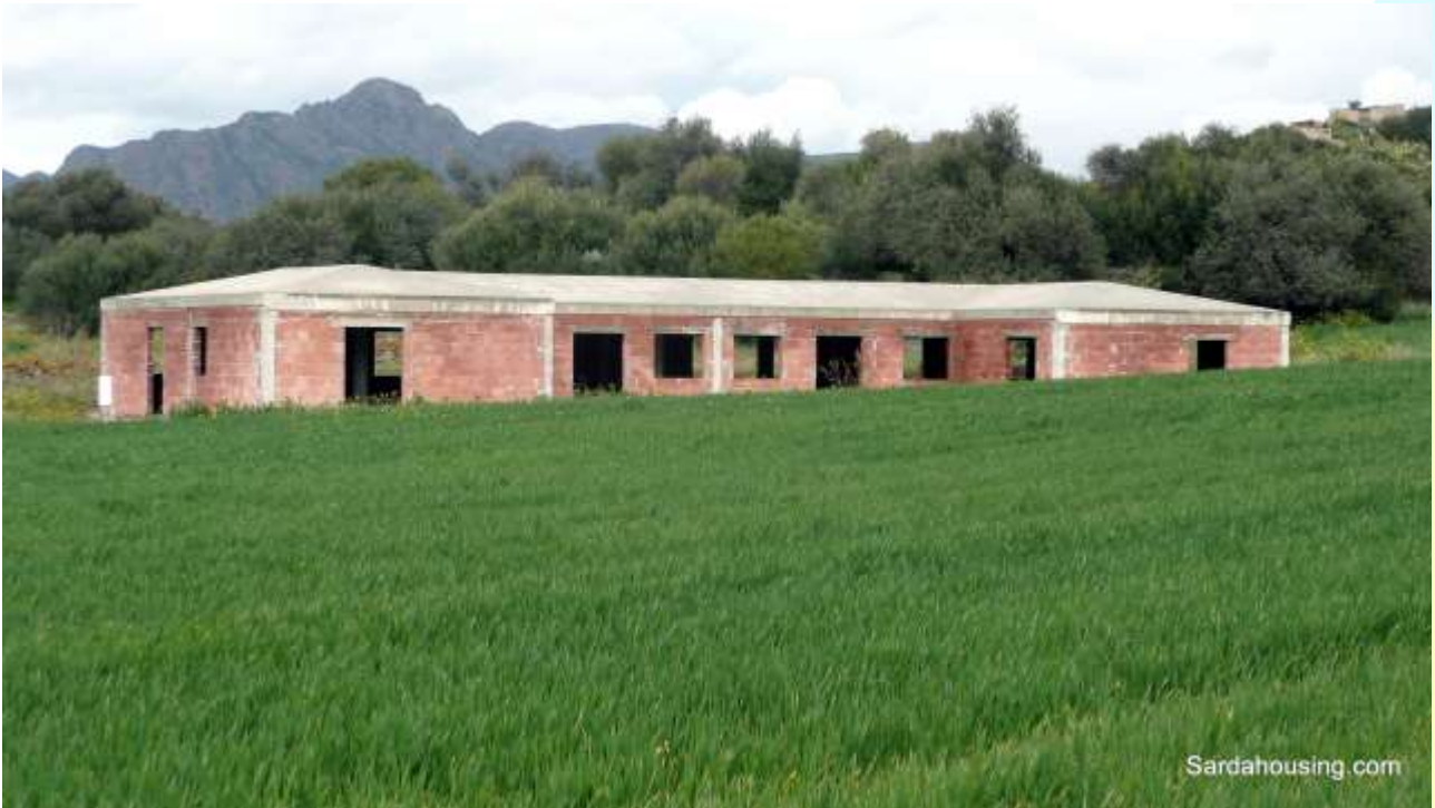
6 - Pula – Terreno Sulcitana: un edificio
