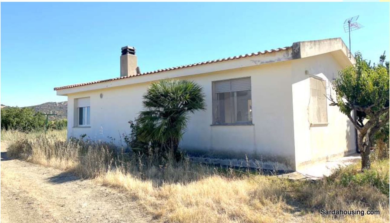
13 - Soleminis – Località Sa Spinarba: warehouse/cellar
