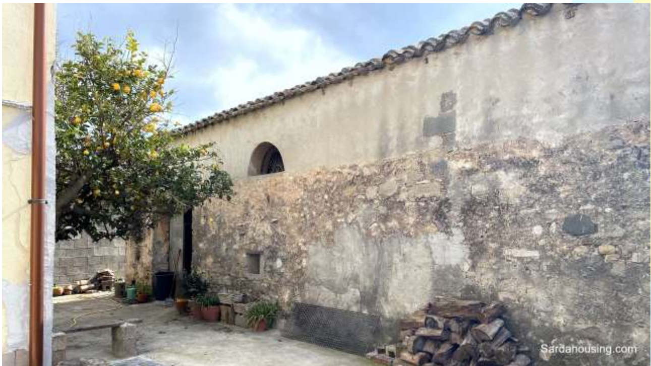
22 - Soleminis – Cagliari – Casa Roma – esterno della cantina in pietra e mattoni
