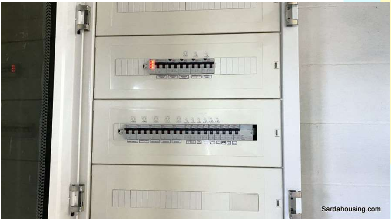
15 - Elmas – zona industriale Casic – Capannone e ufficio in affitto - dettaglio
