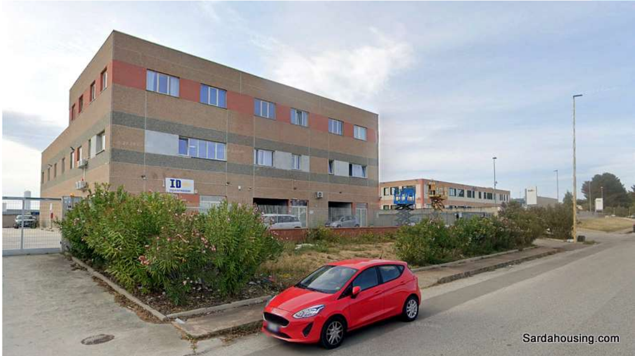
1 – Elmas – zona industriale Casic – Capannone e ufficio in affitto - esterni
