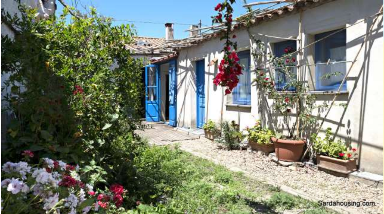
1 – Cabras – centro storico – Casa Green – Campidanese ristrutturata
